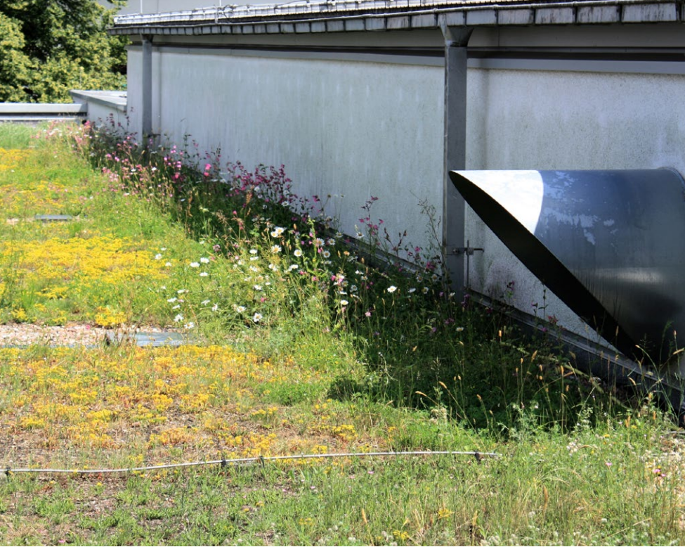
Abb. 17: Kleinräumig variierende Standortbedingungen führen bei identischer Saatmischung zu unterschiedlichem Aufwuchs. Bei der wuchskräftigen kräuterreichen Vegetation im Schatten (rechts im Bild) empfiehlt sich eine Mahd im Spätsommer/Herbst. Der besonnte niedrigwüchsige Bereich (links im Bild) wurde auch im zweiten Jahr nicht gemäht.
