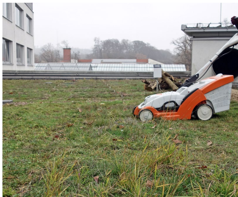
Abb. 18: Für die Mahd der Dachvegetation ist ein konventioneller Rasenmäher mit Auffangkorb für das zu entfernende Schnittgut optimal. Auch bei einer Pflege mittels Motorsense sollte die Biomasse abgeräumt werden.
